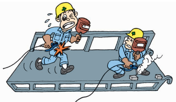
Ang electric shock na nararanasan kapag sumalang ang tagiliran ng katawan sa elektrod habang bumubuo ng bakal na ramp.
